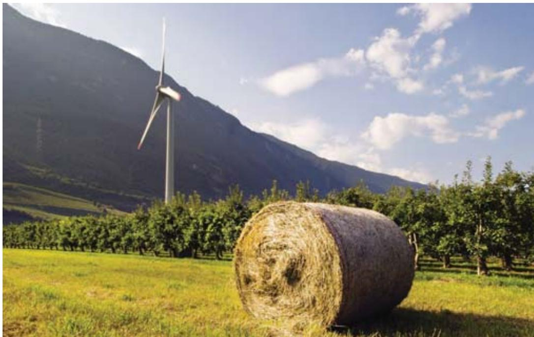
Les pales ont une longueur de 48,50 mètres, pèsent chacune 21 tonnes et affichent une puissance de 3000 kW. Elles balaient une surface de plus de 8000 m<sup>2</sup>, effectuant entre 4 et 14 tours par minute. HOFMANN
